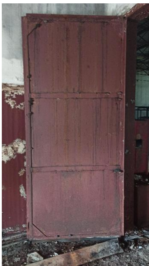
Рис. 42-43. Повреждение коррозией дверных полотен и коробки
