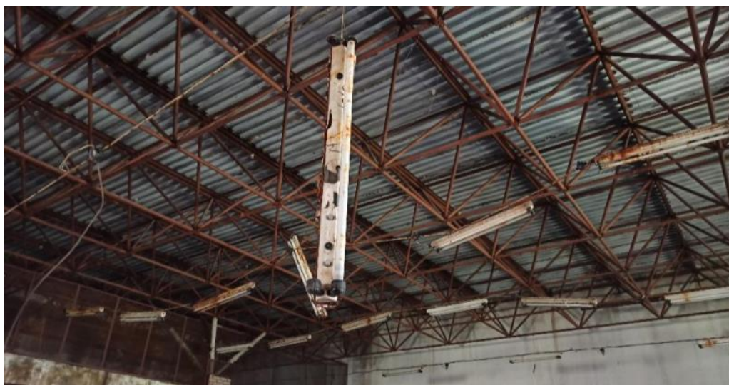
Рис. 48. Износ системы электроосвещения, фактическая неработоспособность системы
