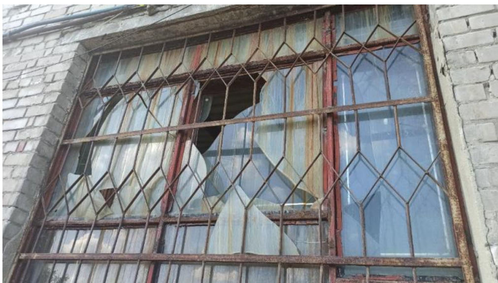
Рис. 40. Коррозия элементов коробки и переплетов, отсутствие остекления местами
