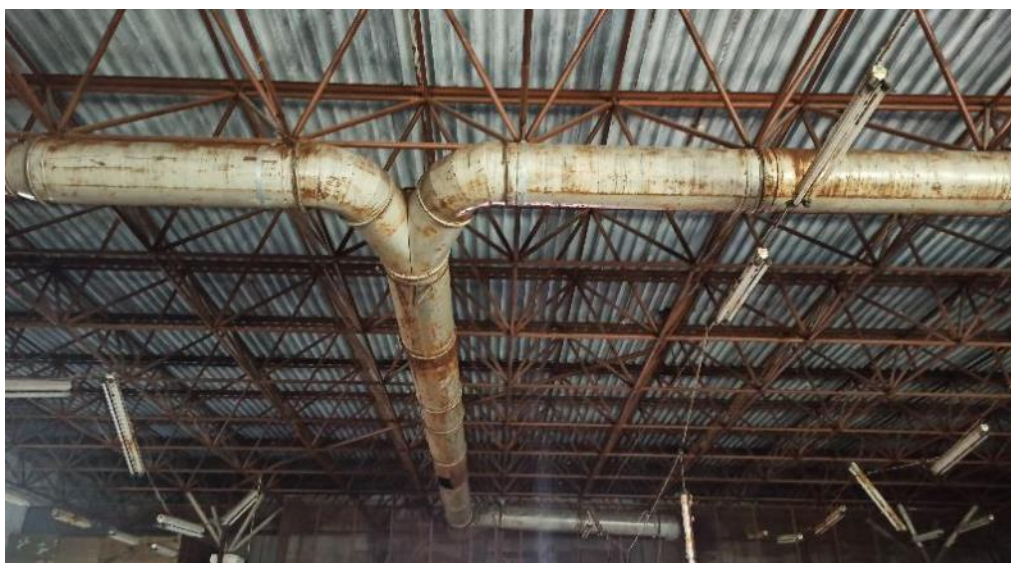
Рис. 28. Коррозия элементов пространственного металлокаркаса. Опасно!
