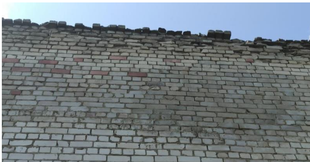
Рис. 17. Выпадение кирпичей, замачивание кладки
