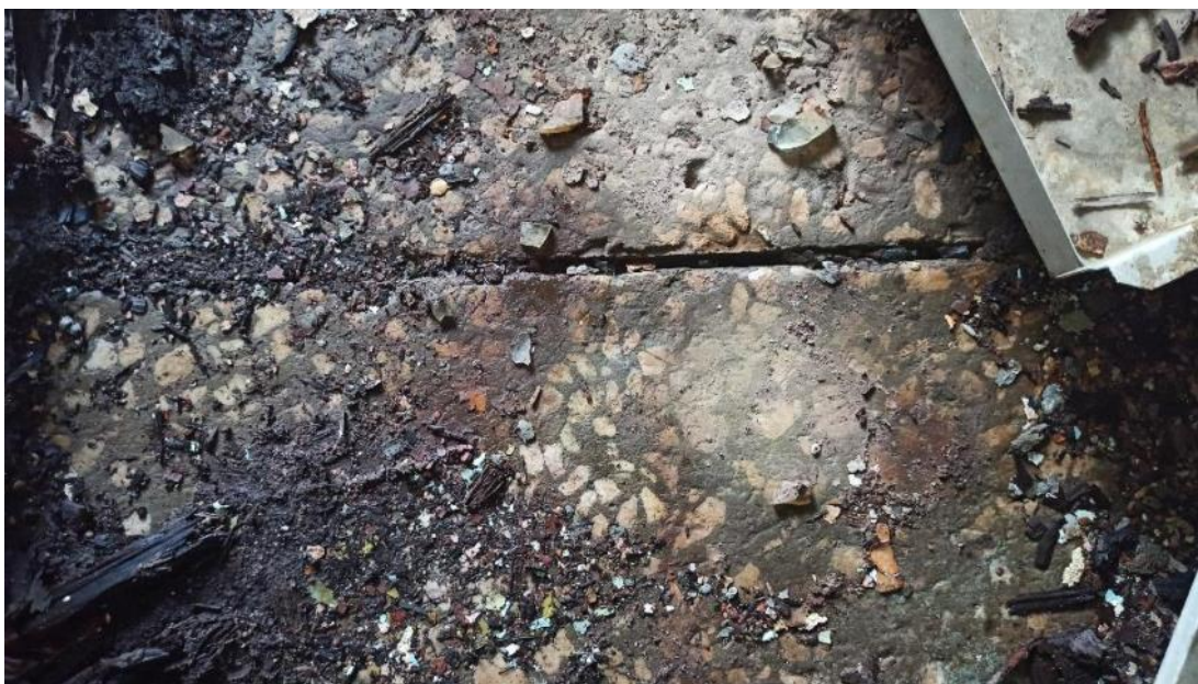
Рис. 35. Замачивание конструкций полов, трещины и сколы, стертость в ходовых местах
