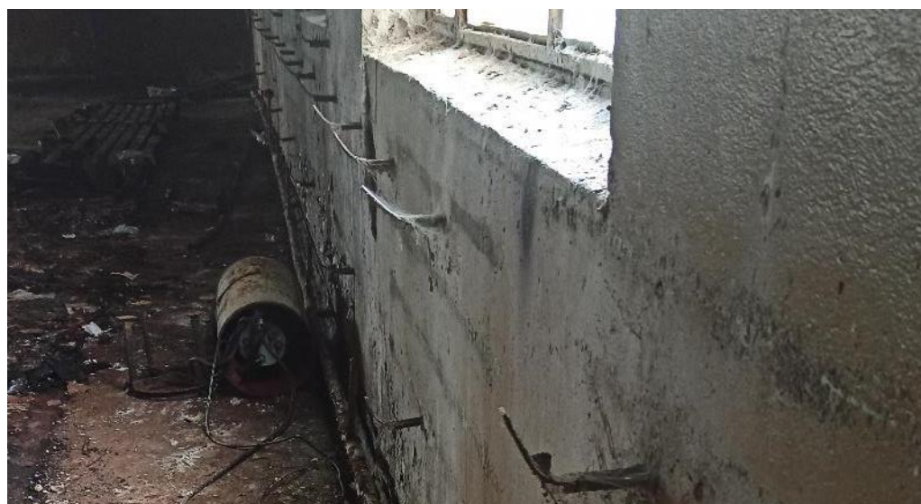
Рис. 49. Отсутствие радиаторов отопления. Состояние – аварийное
