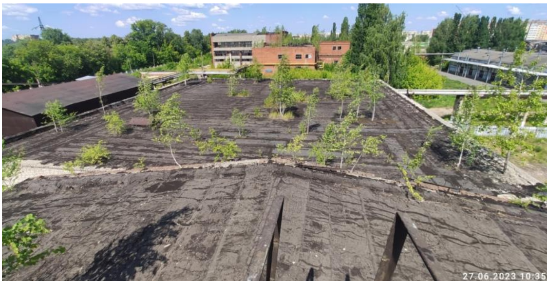
Рис. 32. Общий вид кровли. Повреждение целостности кровли, вздутия и разрывы, рост растительности на кровле
