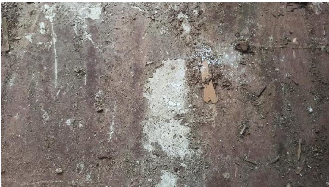
Рис. 36. Износ покрытия полов, рост органики на поверхности
