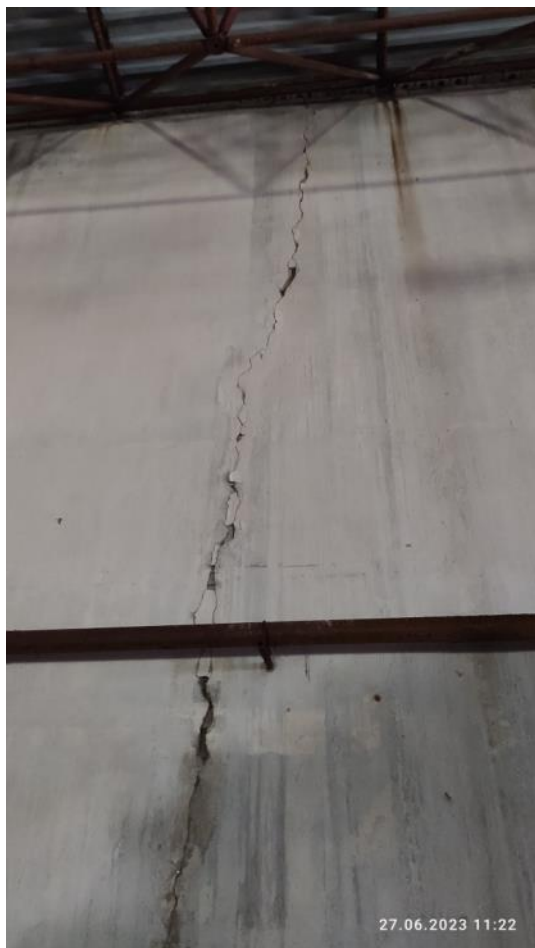
Рис. 24-25. Сквозные трещины в перегородках
