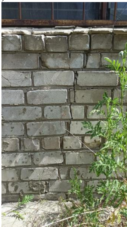
Рис. 11. Трещины в цокольной части из-за неравномерной осадки фундамента
