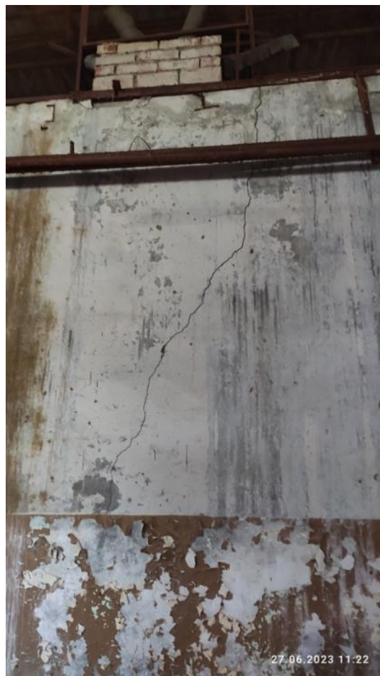
Рис. 24-25. Сквозные трещины в перегородках
