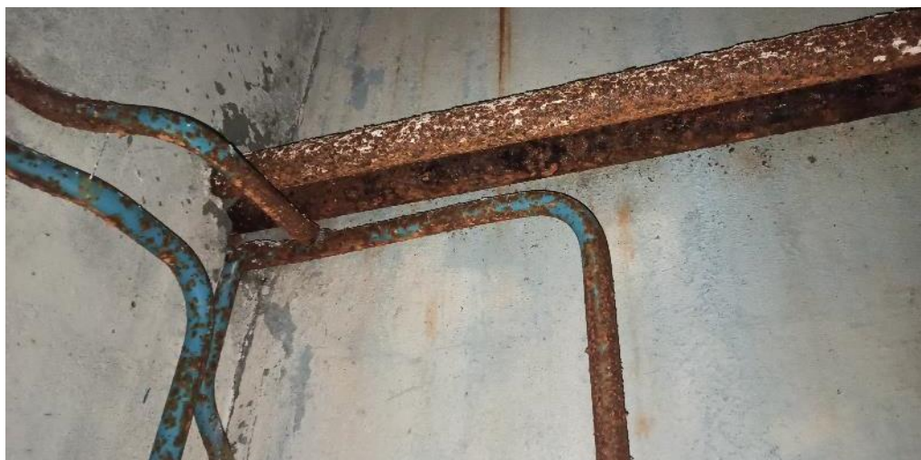
Рис. 51. Поражение коррозией трубопроводов водоснабжения
