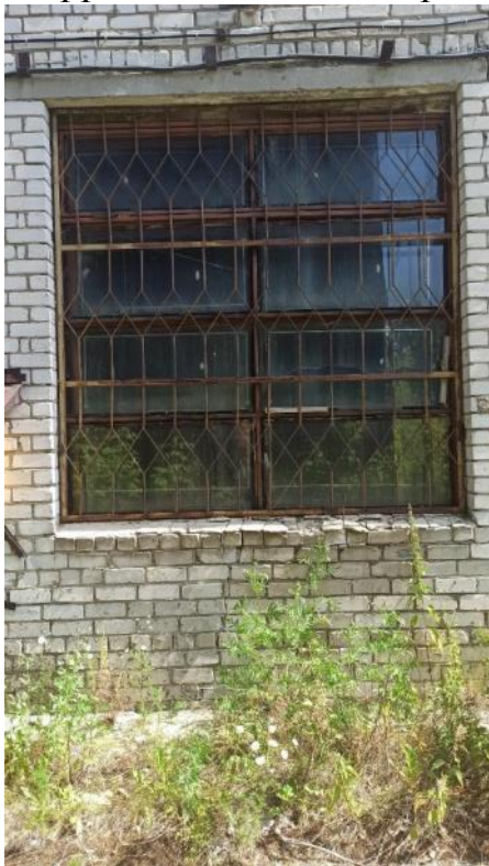
Рис. 38-39. Трещины на стеклах, износ уплотнительных прокладок, коррозия элементов коробки
