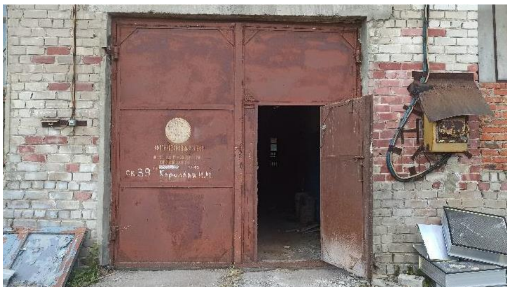
Рис. 41. Коррозия дверных полотен, петель, закладных деталей
