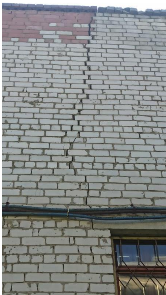
Рис. 19-20. Крупный план на сквозную трещину на северо-западном фасаде (снаружи и изнутри здания)
