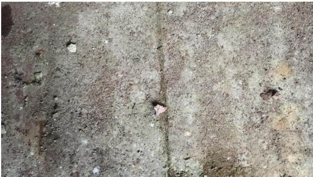
Рис. 34. Мелкие выбоины и трещины на покрытии полов
