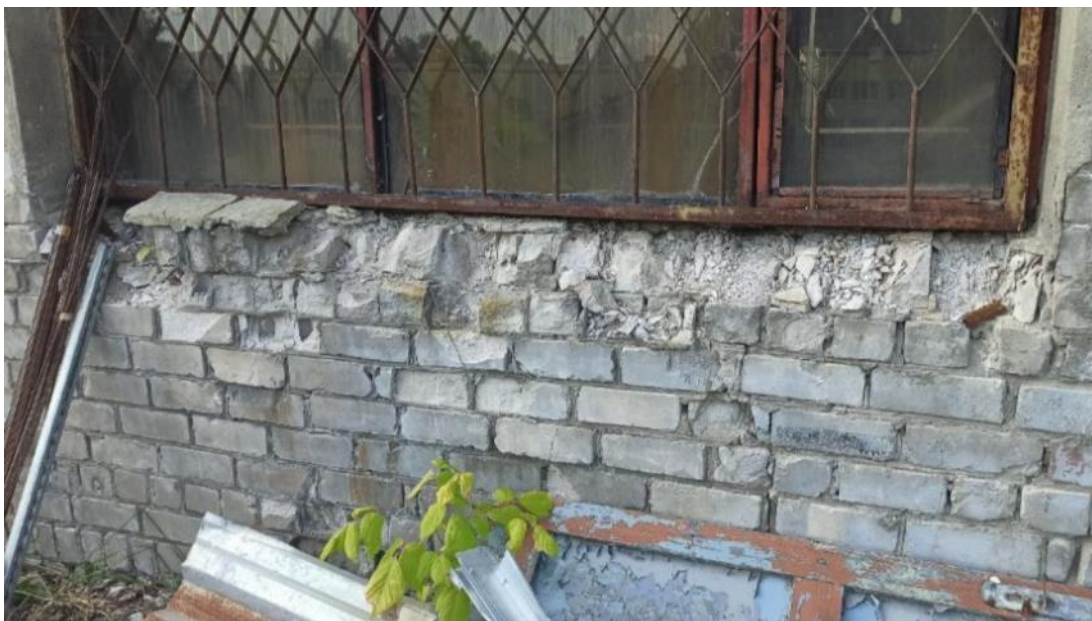
Рис. 18. Сколы отдельных кирпичей, выкрашивание кирпича в подоконной зоне
