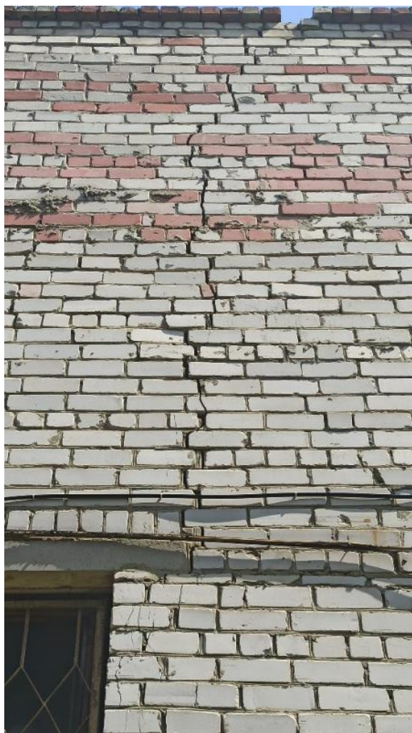
Рис. 22-23. Сквозная трещина на юго-западном фасаде здания (вид снаружи и изнутри здания)
