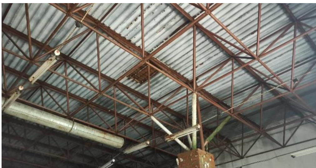
Рис. 30. Ослабление узлов крепления элементов металлокаркаса
