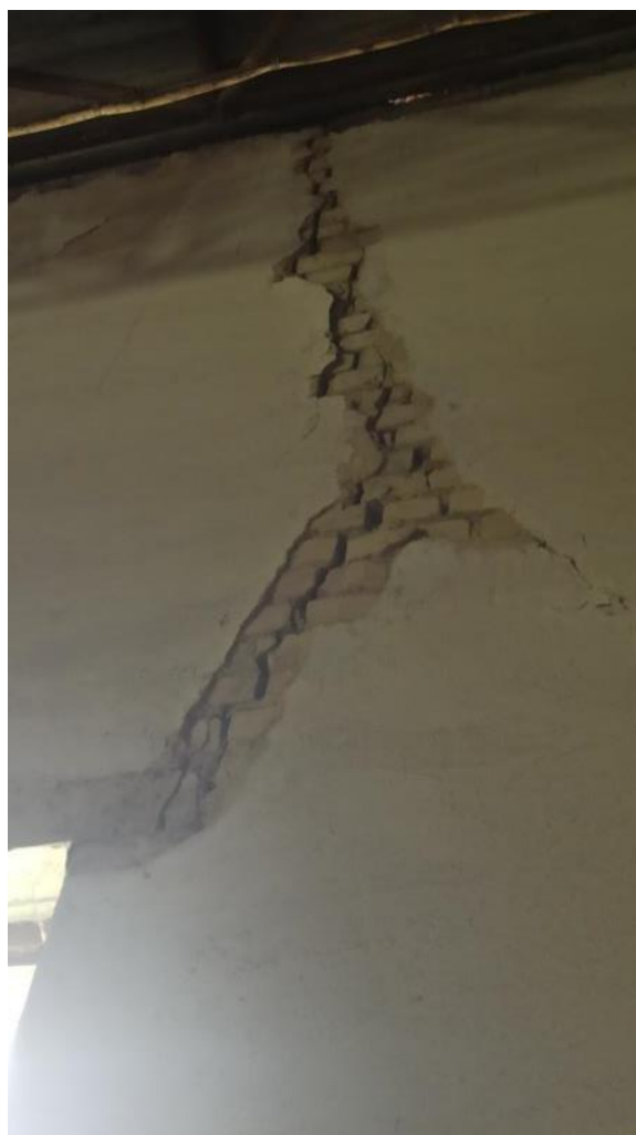
Рис. 19-20. Крупный план на сквозную трещину на северо-западном фасаде (снаружи и изнутри здания)
