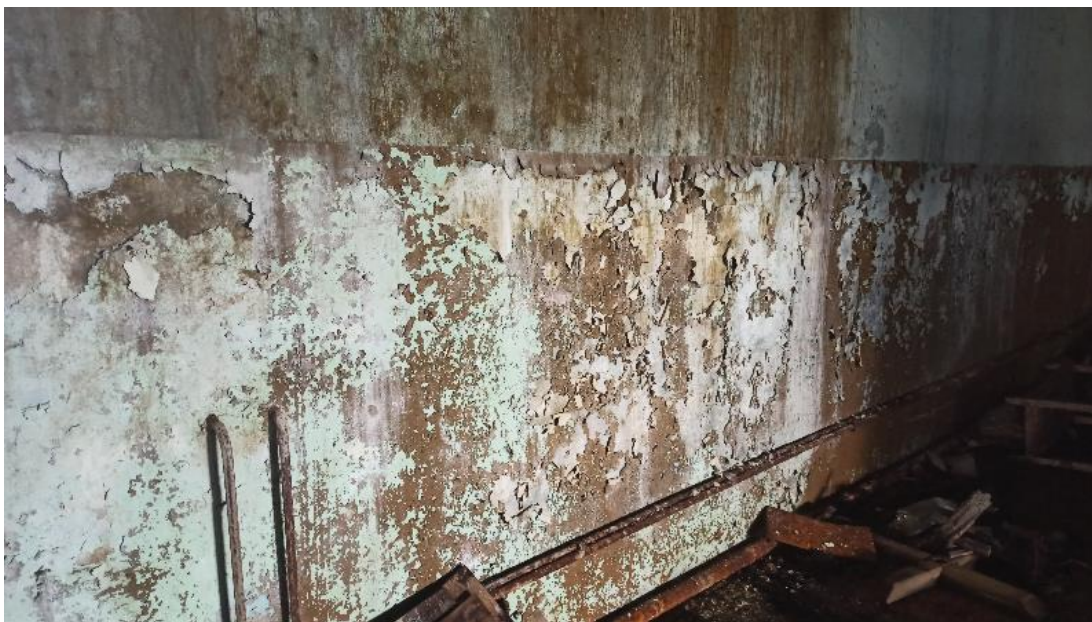
Рис. 44. Биоповреждение отделочного слоя, потемнение и загрязнение, растрескивание
