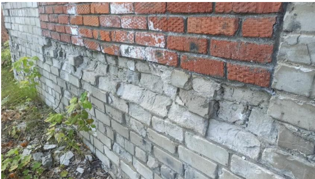
Рис. 21. Разрушение кладки на глубину до 120 мм
