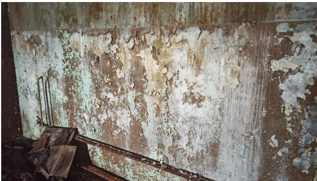
Рис. 45. Сплошное замачивание отделочного покрытия, биоповреждение стен
