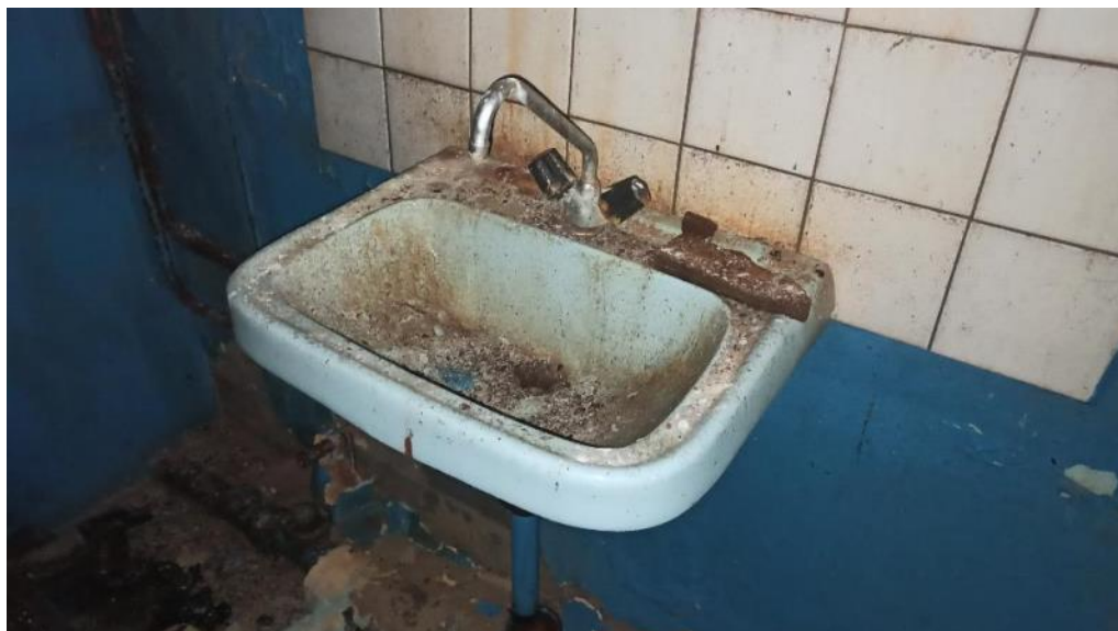
Рис. 53. Износ внутренних санитарно-гигиенических устройств
