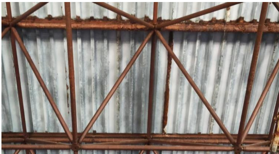
Рис. 31. Поражение коррозией элементов трубчатого сечения конструкций покрытия
