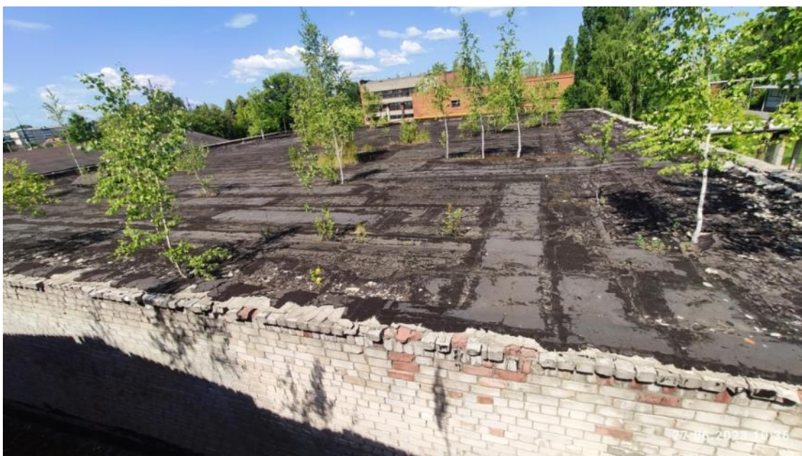
Рис. 33. Повреждение целостности кровли, трещины и разрывы, неплотности прилегания кровли к нижележащим слоям. Рост растительности на поверхности
