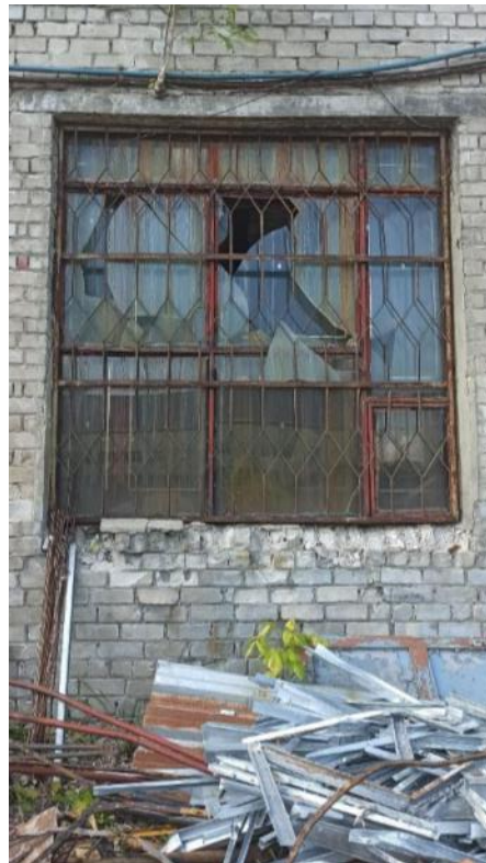
Рис. 38-39. Трещины на стеклах, износ уплотнительных прокладок, коррозия элементов коробки
