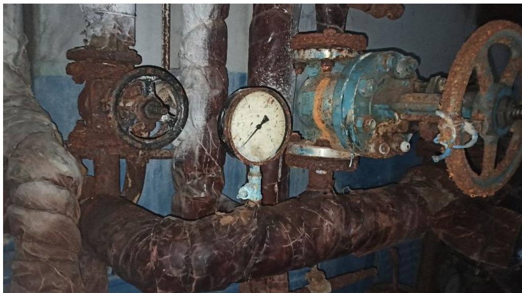
Рис. 50. Поражение коррозией трубопроводов и запорной арматуры системы отопления
