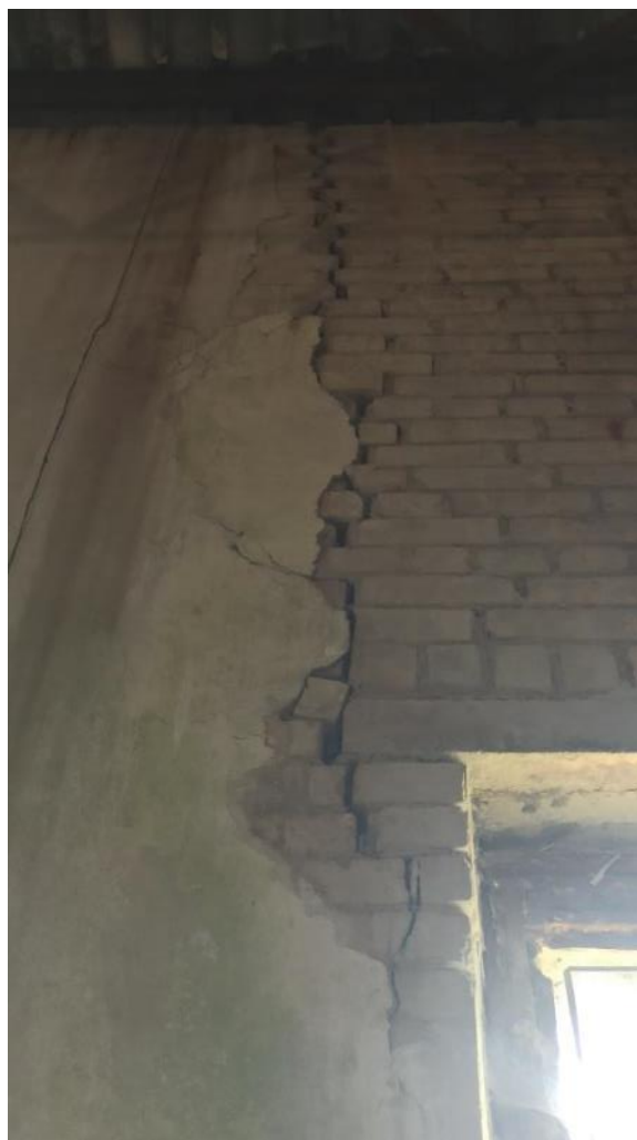
Рис. 22-23. Сквозная трещина на юго-западном фасаде здания (вид снаружи и изнутри здания)
