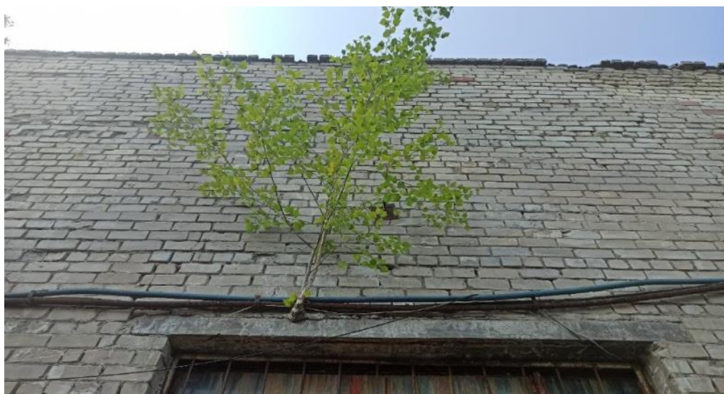
Рис. 16. Рост растительности на стеновых ограждающих конструкциях, сколы отдельных кирпичей, в частности в подкарнизной зоне
