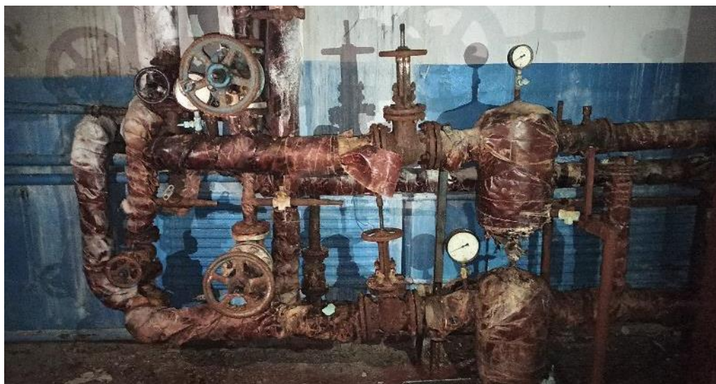
Рис. 52. Поражение коррозией и фактическая неработоспособность системы отопления (вид на тепловой узел)
