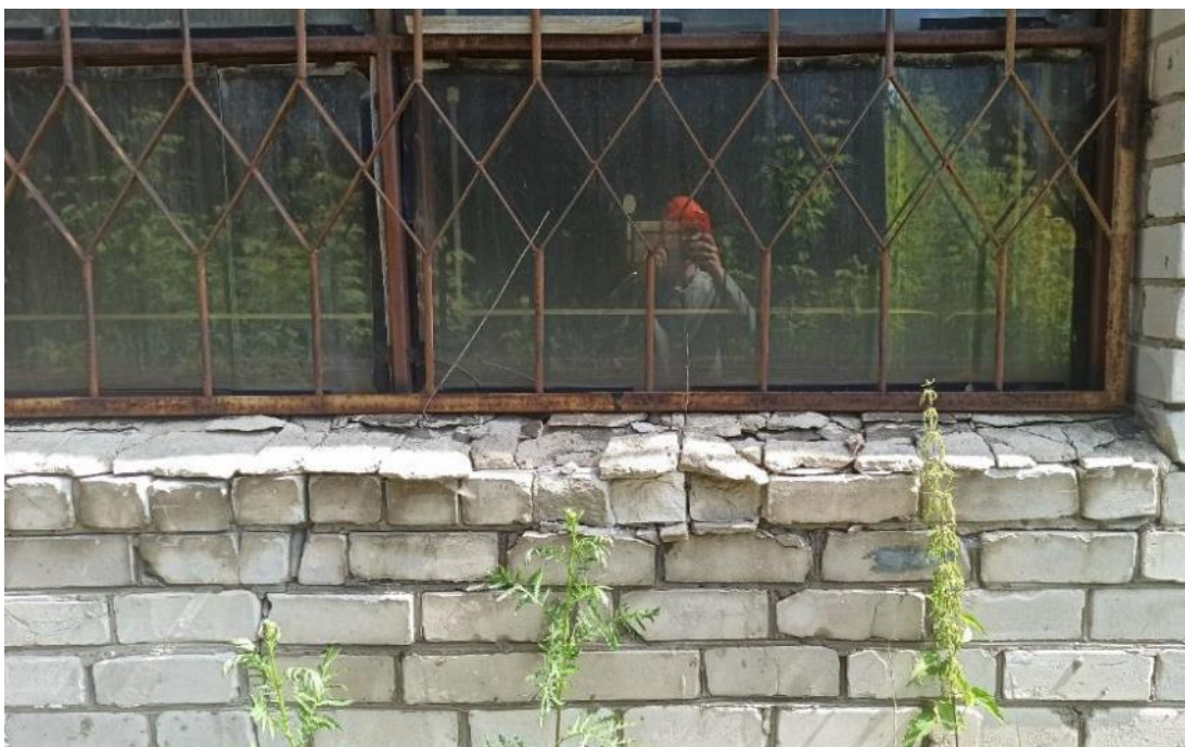
Рис. 41. Износ элементов оконных заполнений. Состояние – аварийное
