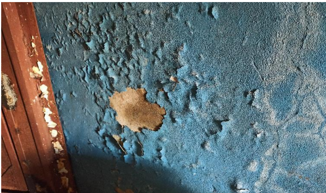
Рис. 46. Растрескивание, отслоение и выпадение отделочного покрытия
