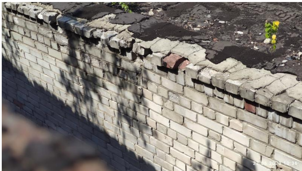
Рис. 15. Выпадение отдельных кирпичей в подкарнизной зоне (юго-восточный фасад)
