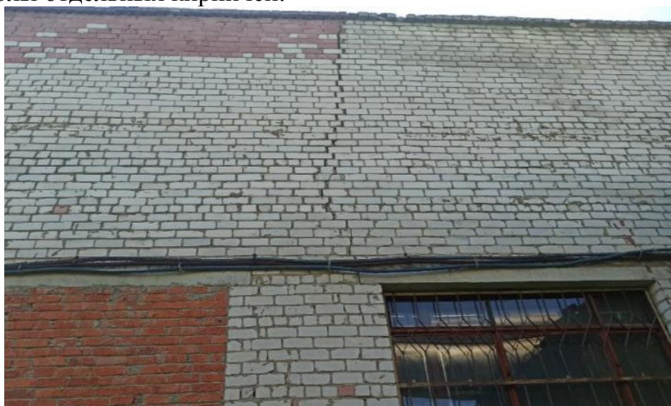
Рис. 14. Сквозная трещина в ограждающей стене на северо-западном фасаде
